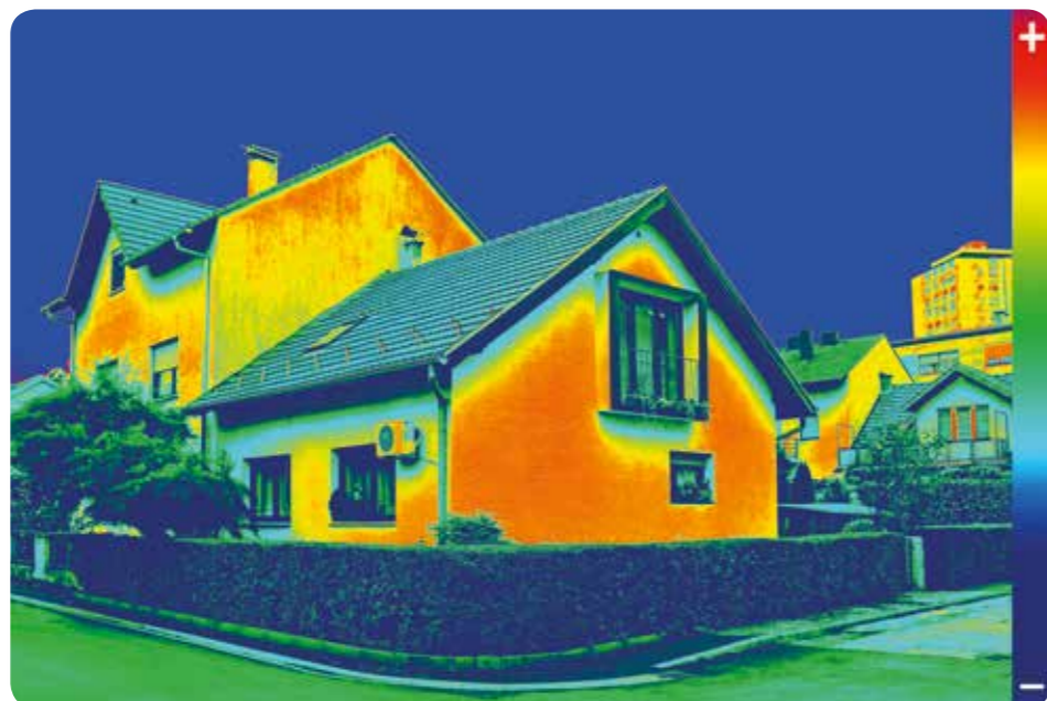
Visione con termocamera delle dispersioni termiche di un edificio non isolato
