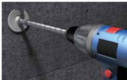
Procedura di installazione termoz SV II ecotwist in pannelli di schiuma rigida di polistirene 032
